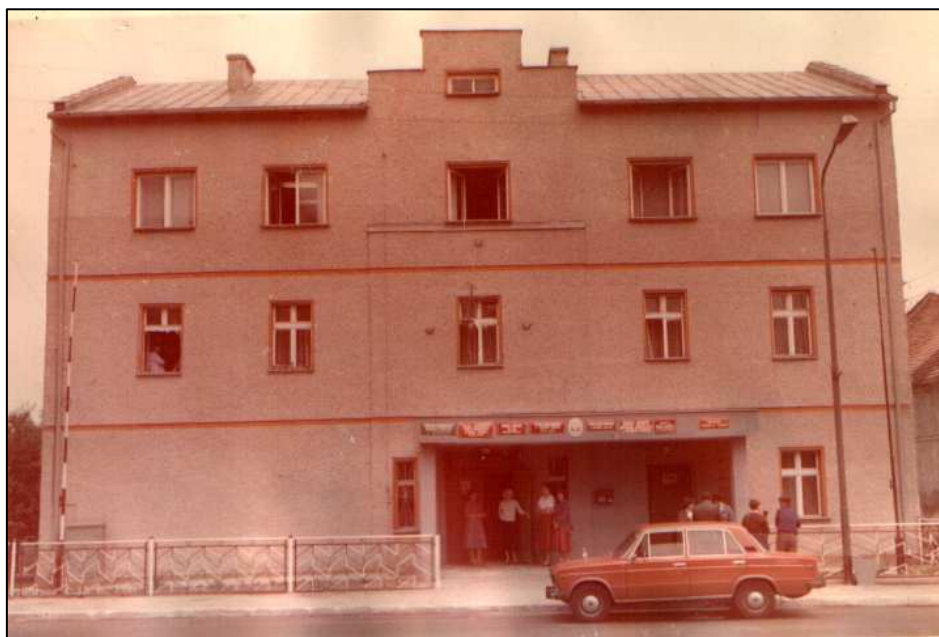
Urząd Gminy w Wądrożu Wielkim po rozbudowie.
